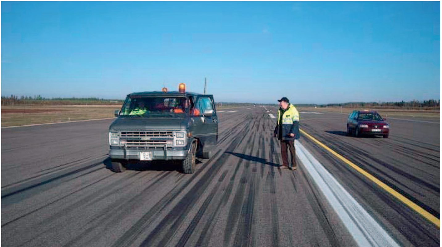
Bild 1: Vorbereitung zur Entnahme der Bohrkerne im Jahre 2008 nach 16 Jahren Liegezeit
