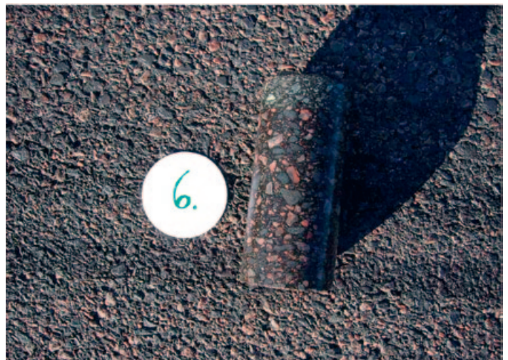
Bild 5: Bohrkern aus Malmö aus dem Jahre 2008
