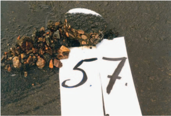
Bild 3: Bohrkern aus Malmö aus dem Jahre 1988
