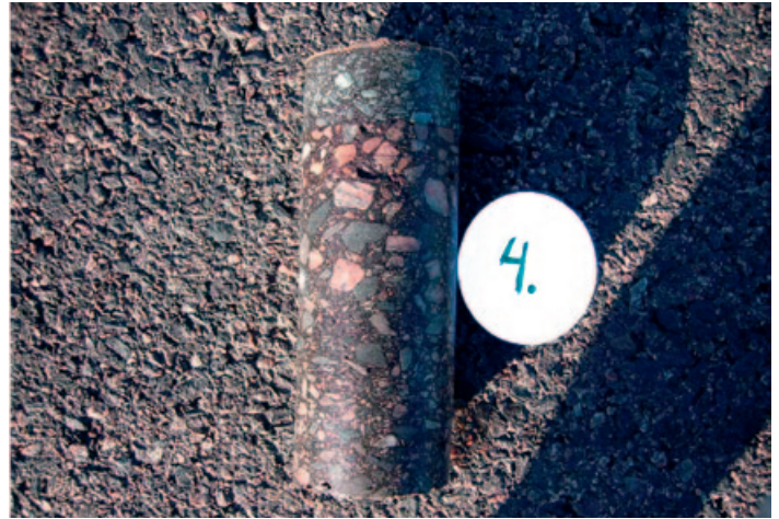
Bild 4: Bohrkern aus Malmö aus dem Jahre 2008
